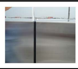
เส้นซิลิโคนทับเต็มร่อง silicone line finish
