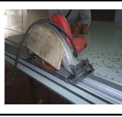
เจาะร่องตามแนวเส้นที่วาดไว้ groove the panel on the mark
