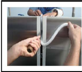
ใส่โฟมเส้นในร่องที่เว้นไว้ fill the foam in the space
