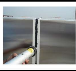
ซิลิโคนทับโฟมเส้น seal the sealant on the foam
